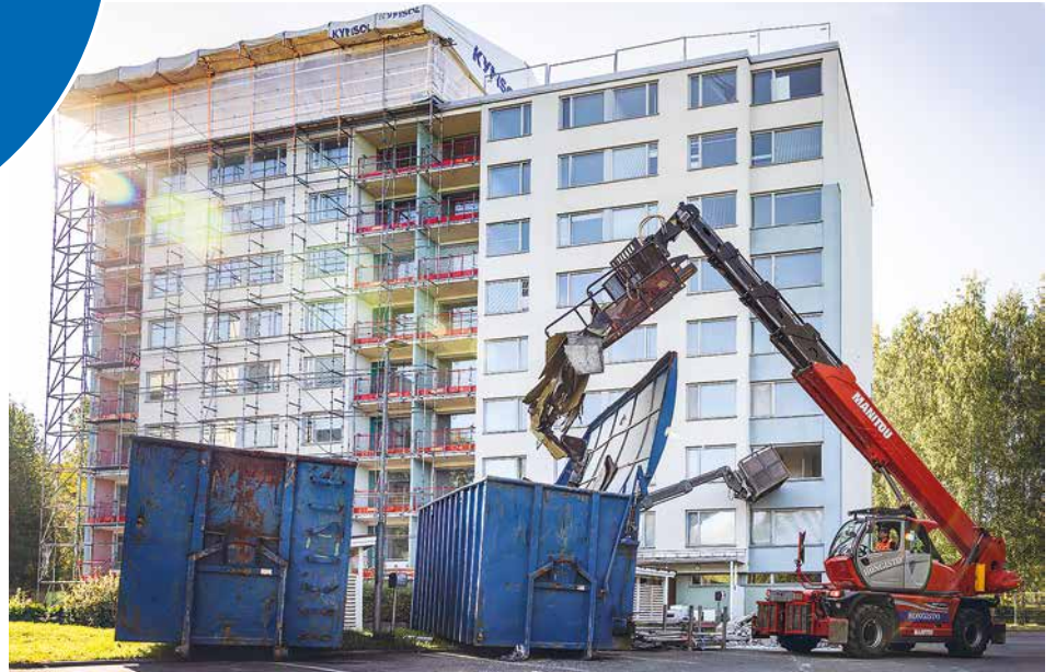
Järvitiien laaja peruskorjaus on alkanut rakenteiden purkutöillä.
