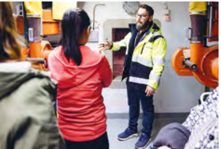
Sivakka järjesti keväällä Maikkulassa mahdollisuuden tutustua väestönsuojaan. Asiantuntijana oli väestönsuojien tarkistuksista vastaava Mika Pyhäjärvi Presto Oy:stä.
